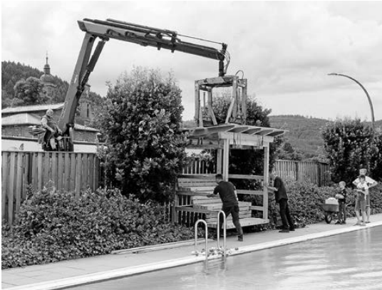
Ende Mai wurde der vormontierte "Schattenplatz" für die Schwimmaufsicht mit einem Kran an die dafür vorbereitete Stelle gehoben.
