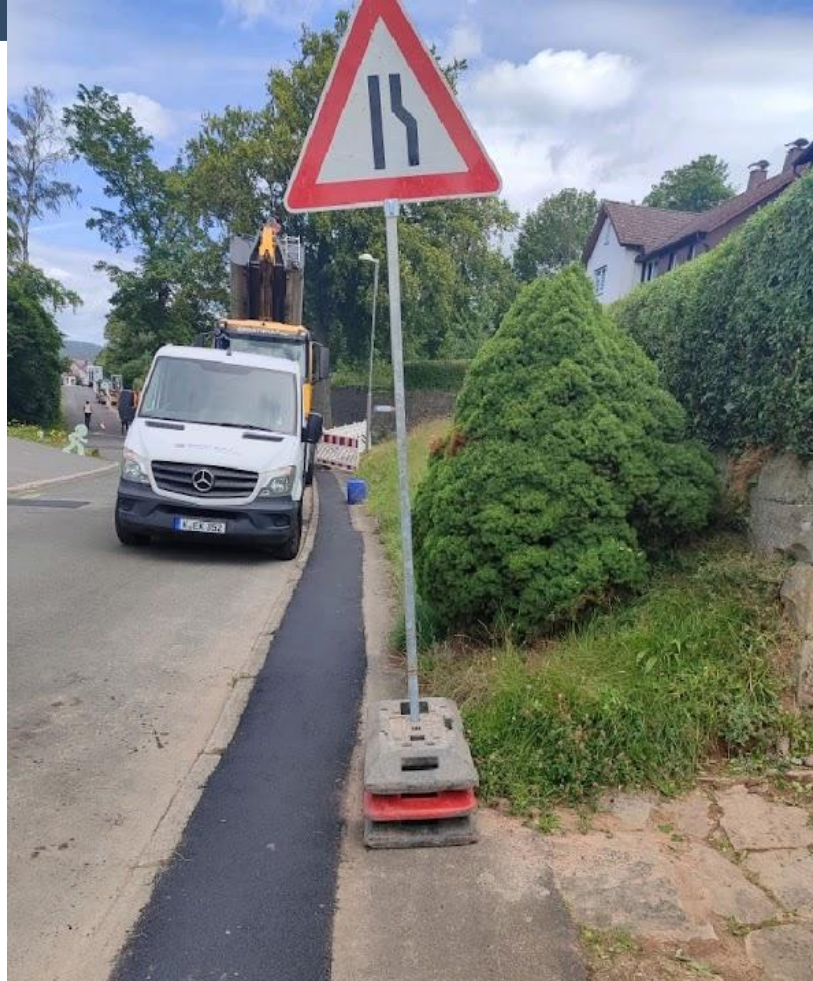
Feinschicht ein paar Tagen später eingebaut
