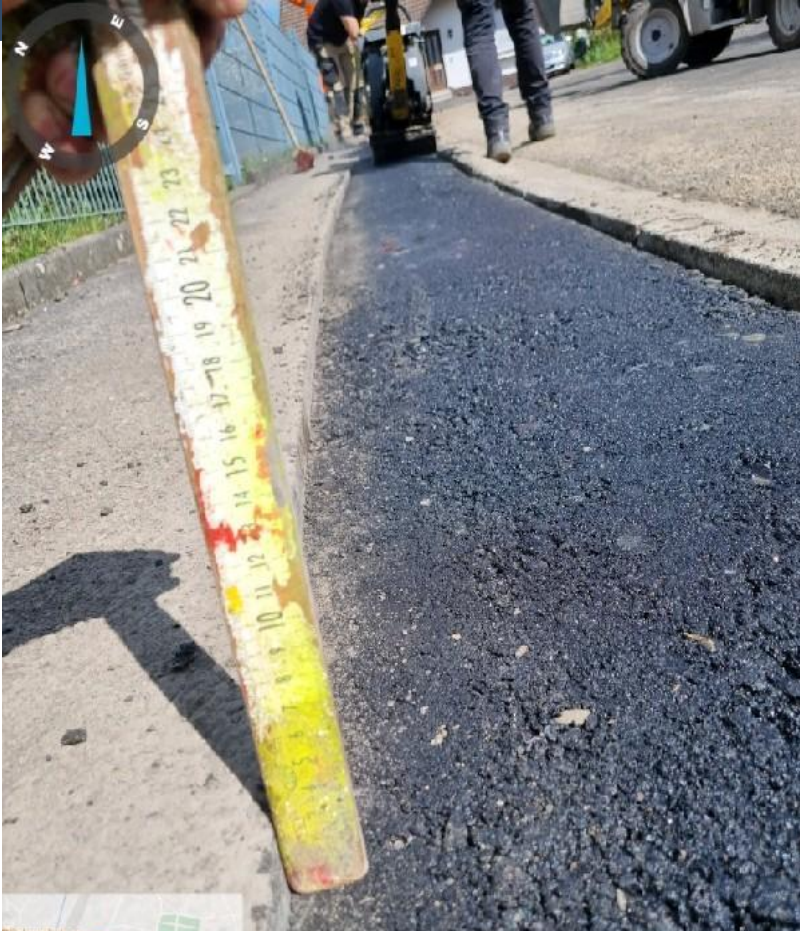
Tragschicht am selben Tag eingebaut
